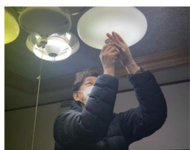
蛍光灯の取り替え
